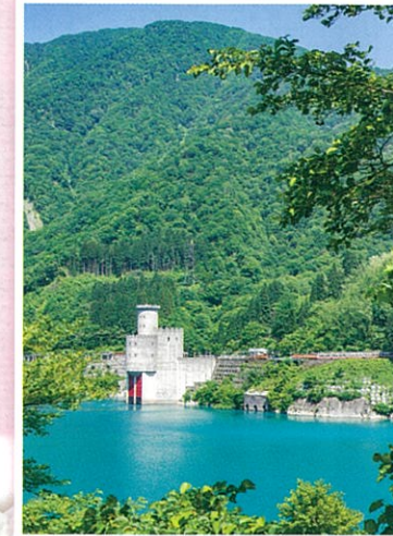
新柳河原発電所
